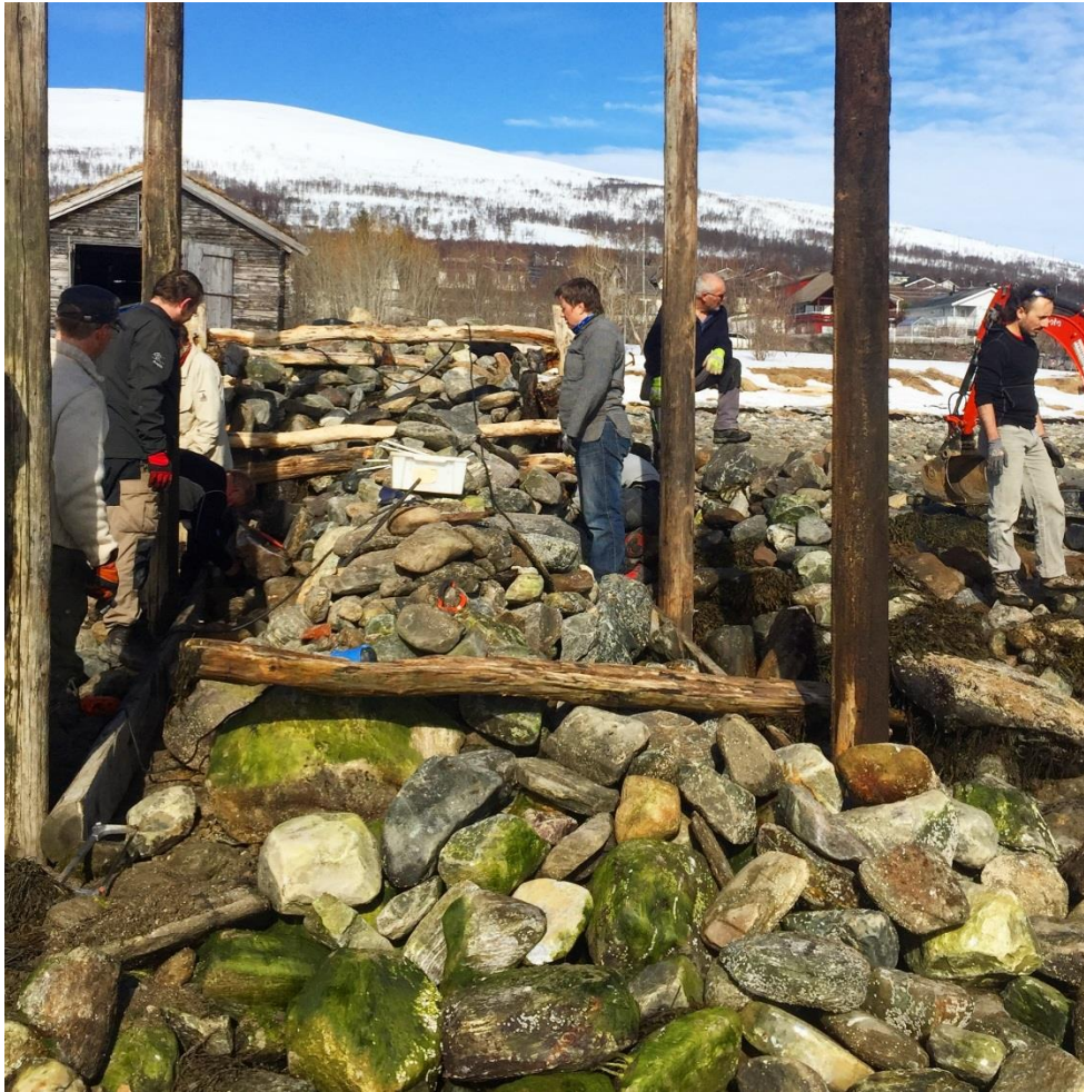
Ytterste del av vorren blir fundamentert før stein fylles i. Foto: Ingrid Sommerseth
