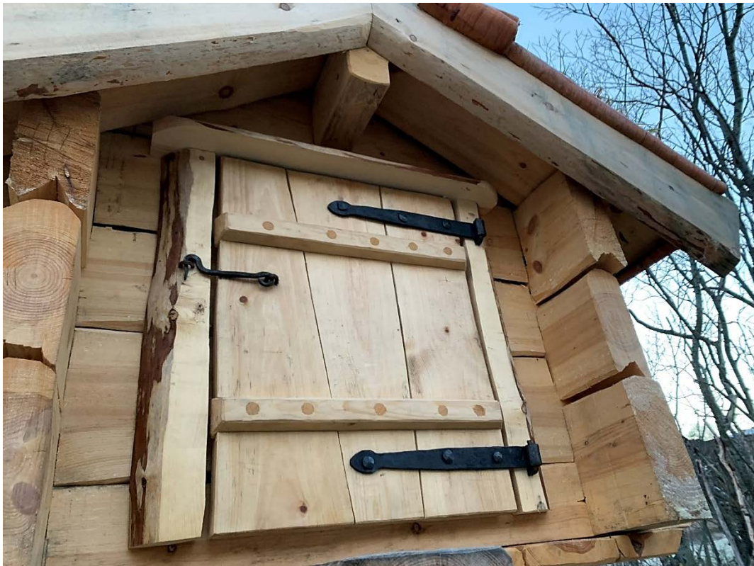
Smiarbeider. Foto: Jan-Tore Ovesen
