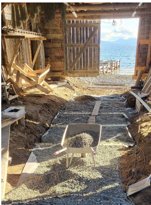
Masser er gravd ut og det fylles på med pukk foto pgeilertsen
